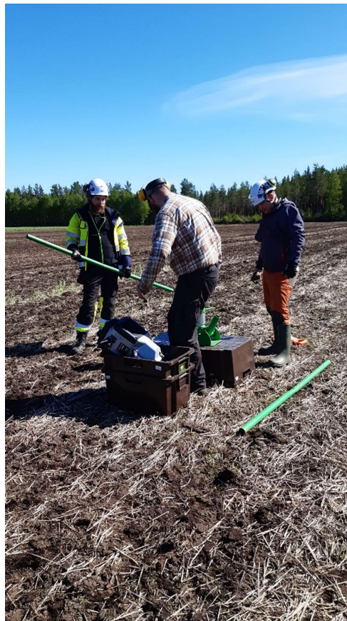
Kuva 6. Pohjavesiputkien asentaminen moottorikairalla viljelijän pellolle (Kuva: Maarit Liimatainen, Luke).
