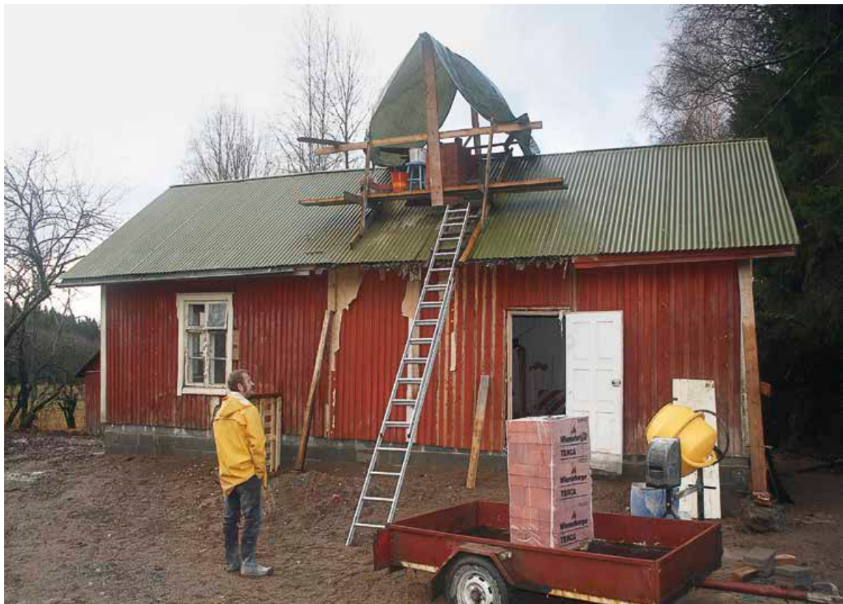
■ Satavuotiasta mökkiä on nostettu puoli metriä, uusi savupiippu on valmistumassa. Petäjäiset hirret osoittautuivat hyväkuntoisiksi. (Esko Kuusisto)
