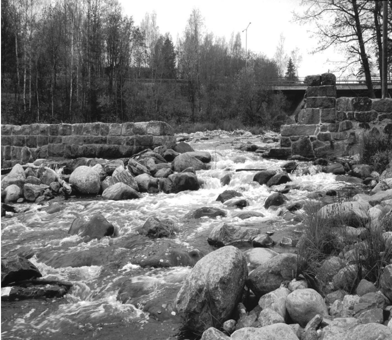
Joen rakenteellisen tilan parantamiseksi on joissakin tapauksissa ehkä purettava patoja tai rakennettava kalateitä - kuvassa Vantaanjoen Vantaankosken luonnonmukainen kalatie. Sen rakentamiseen liittyen koskessa oleva pato on osittain purettu. Kuva: Tero Taponen.
