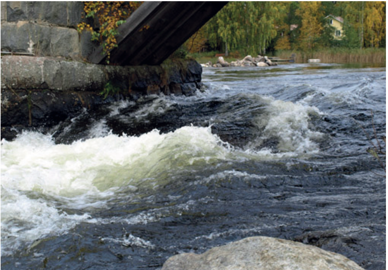
Kuva 32. Heinäveden Kermankoskeen rakennettiin koskimelojia varten "stoppari".
