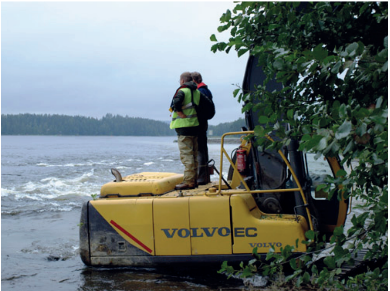
Kuva 11. Kaivinkoneen kuljettajaa ohjeistetaan kivien asetteluun kunnostettavassa koskessa.
