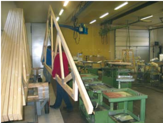
Talovalmistajat ja niiden alihankkijat toimivat tiiviisti yhteistyössä. Kuva on otettu SHR-Produktin tiloissa Pedersöressä. Yritys on erikoistunut kattoristikoiden valmistukseen. Kuva: Mårten Lövdahl.
