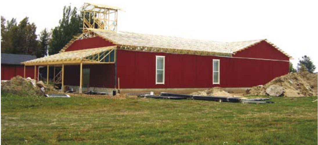
Yhdistetty puusepänverstas ja myymälä Ryhti-elementeistä avaimet käteen toimituksena. Rakennuksen koko 600 m 2 . Kuva: Tapani Kaipio.
