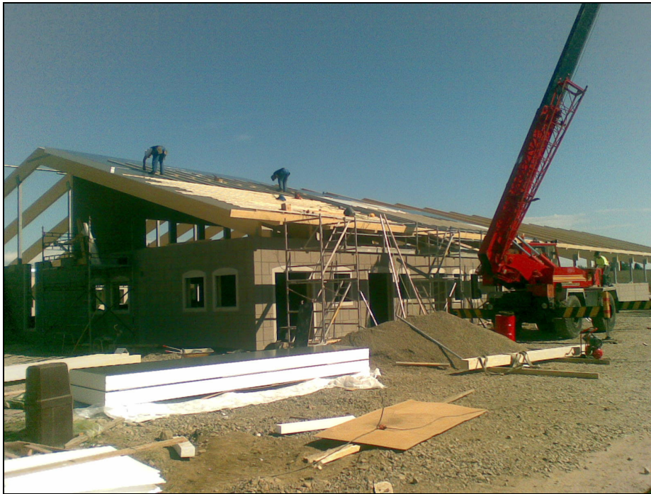
Kuva 5: Maaningan navetan rakennusvaihe 31.7.2008
