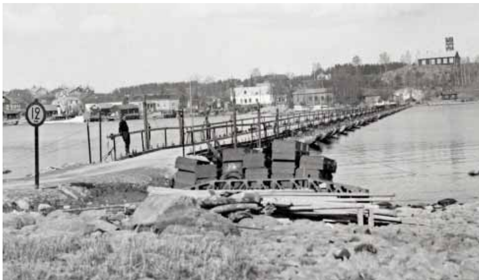
■ Toisen maailmansodan aikana pioneerit rakensivat Puumalansalmen yli ponttoonisillan. Se helpotti sotatarvikkeiden kuljetusta ja myös monen siirtolaisen taival länttä kohti kulki sen yli. Lisäksi lossi oli käytössä. (Museovirasto)
