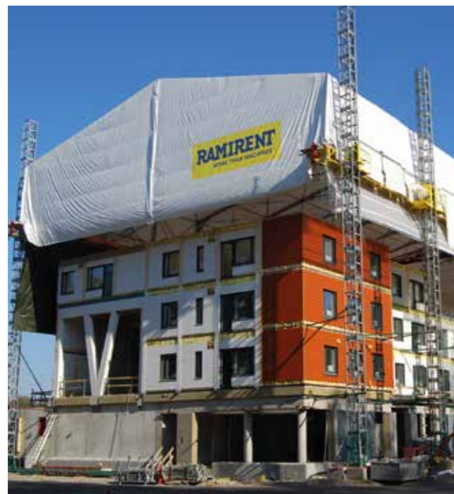
Bild 6. Ett höghus av trä som byggs för bostadsmässan i Ylästö i Vanda 2015. (Foto: Rakennusliike Reponen)
